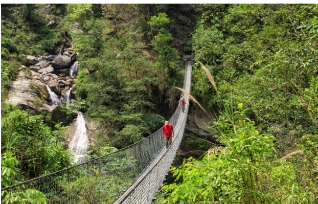
Le pont métallique construit en 2009
