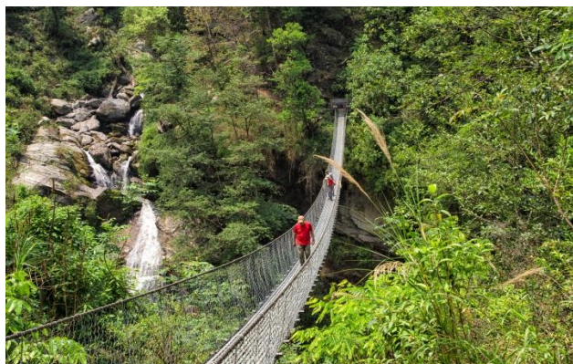
Le pont métallique construit en 2009
