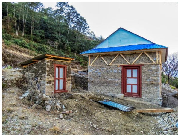
Maison et toilettes parasismiques construites en janvier 2019
